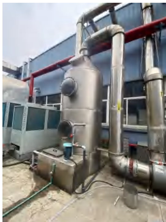
1#PVDF 膜/PES 膜/尼龙膜制膜废气/溶 剂废气/蒸馏塔冷凝尾气处理设施 (水喷淋)
