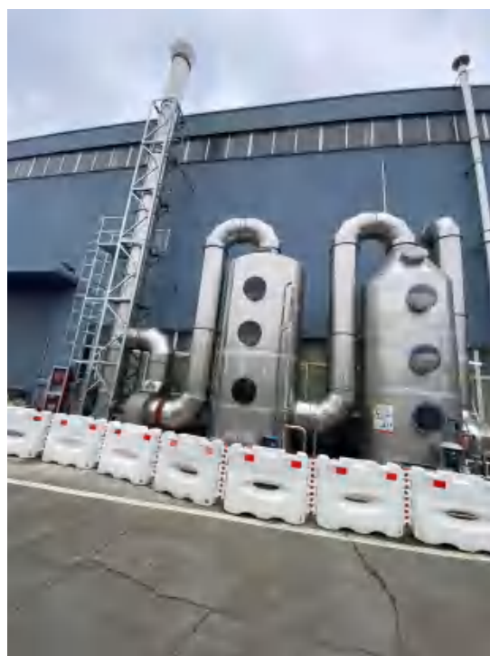
1#层析膜/中空纤维膜制膜废气处理设 施 (两级水喷淋)
