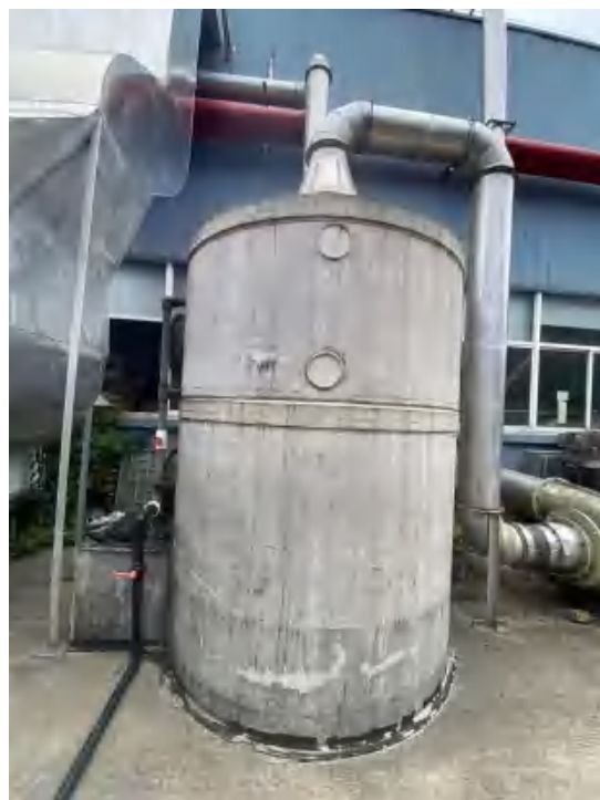
3#PVDF 膜/PES 膜/尼龙膜制膜废气/溶剂废气/蒸馏塔冷凝尾气处理设施 (水喷淋)
