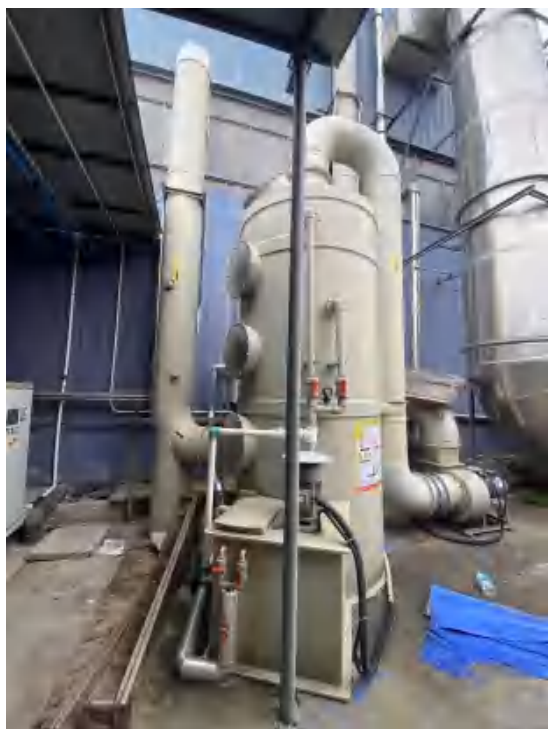
热压废气处理设施 (水喷淋)
