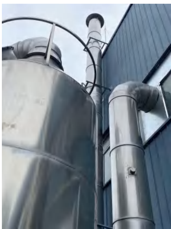
3#纳米纤维膜制膜废气处理设施 (水喷淋)
