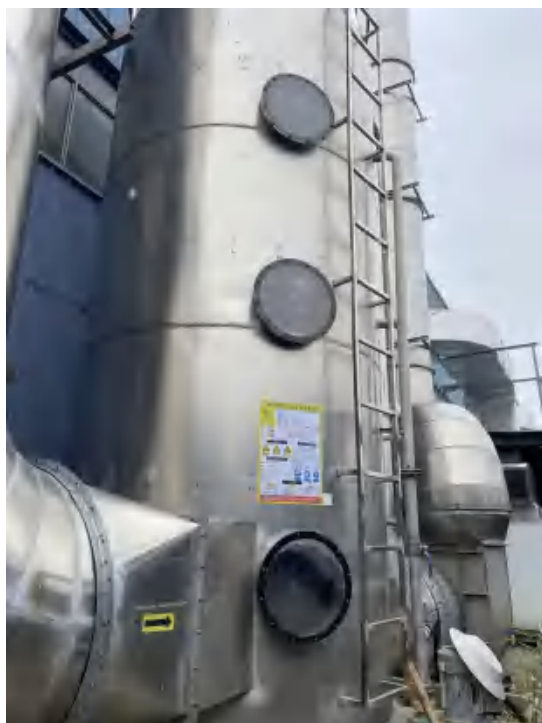
熔喷滤芯的熔喷成型废气处理设施 (水喷淋)
