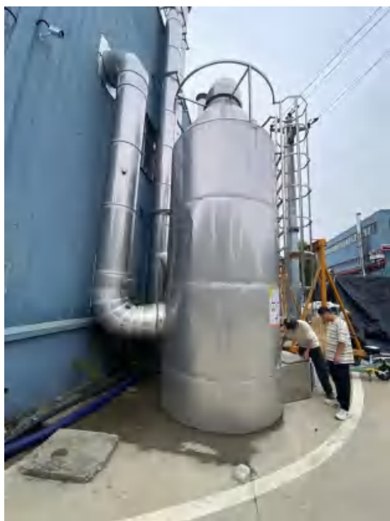
1#纳米纤维膜制膜废气处理设施 (水喷淋)
