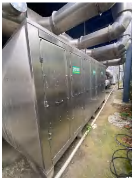
PTFE 膜/防尘膜的制膜废气、熔喷布的 熔喷成型废气、胶水废气、模具煅烧废 气处理设施(活性炭吸附)
