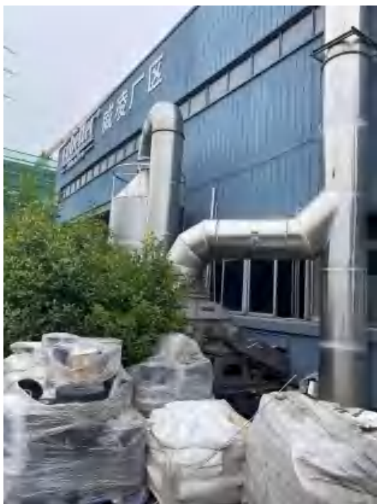
1#PTFE 膜/防尘膜制膜废气处理设施 (水喷淋)
