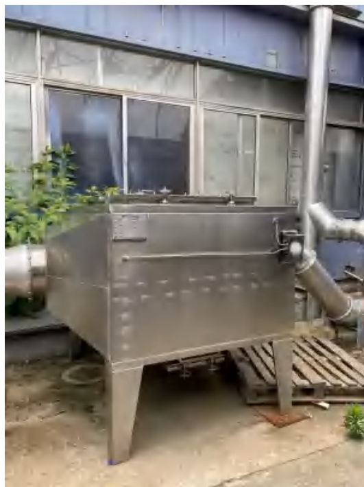
2#PTFE 膜/防尘膜制膜废气处理设施 (活性炭吸附)
