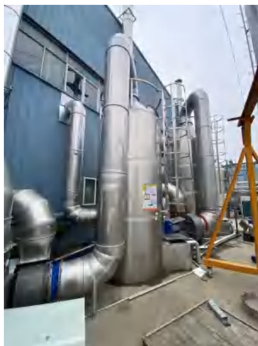
2#纳米纤维膜制膜废气处理设施 (水喷淋)
